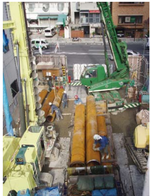
「プラント上から撮影」
