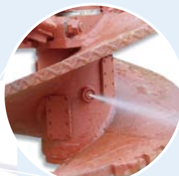
高圧水排出部分拡大
